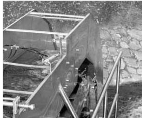
Das gereinigte Wasser wird wieder in den Frohnbach geleitet.
