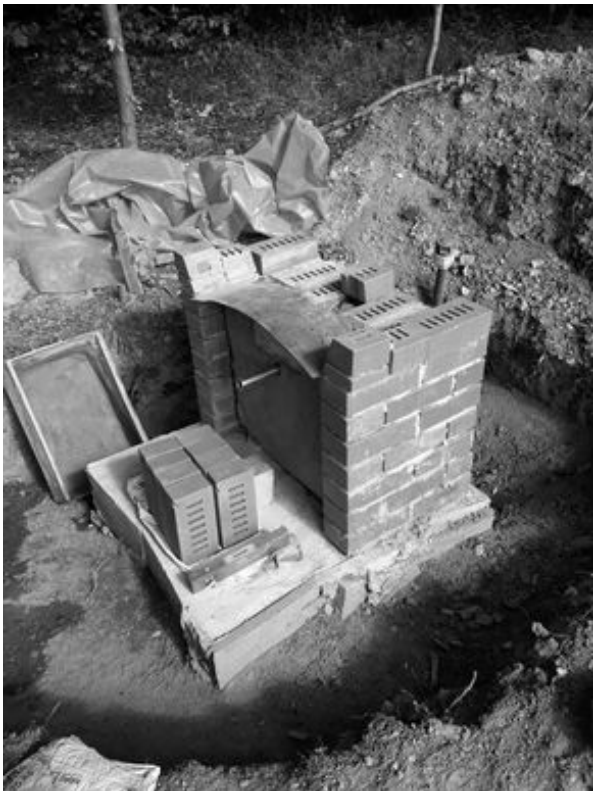
Baustand des Auslaufbauwerks im Juli 2023
